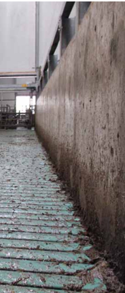
Sparer skatt: Far og sønn Zeeborg har investert i grønne gulv for å oppnå status som miljøgård. Grønne gulv med flapper kan redusere ammoniakkutslippene med opptil 50 prosent.
